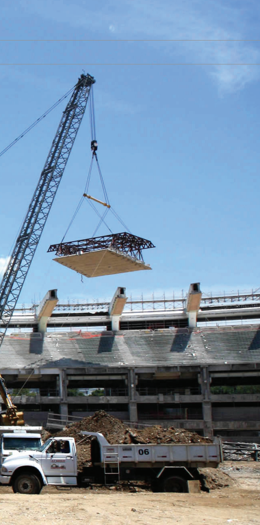
◀ Remoção das placas de concreto que faziam a cobertura do estádio do Maracanã consumiu cinco meses de trabalho
