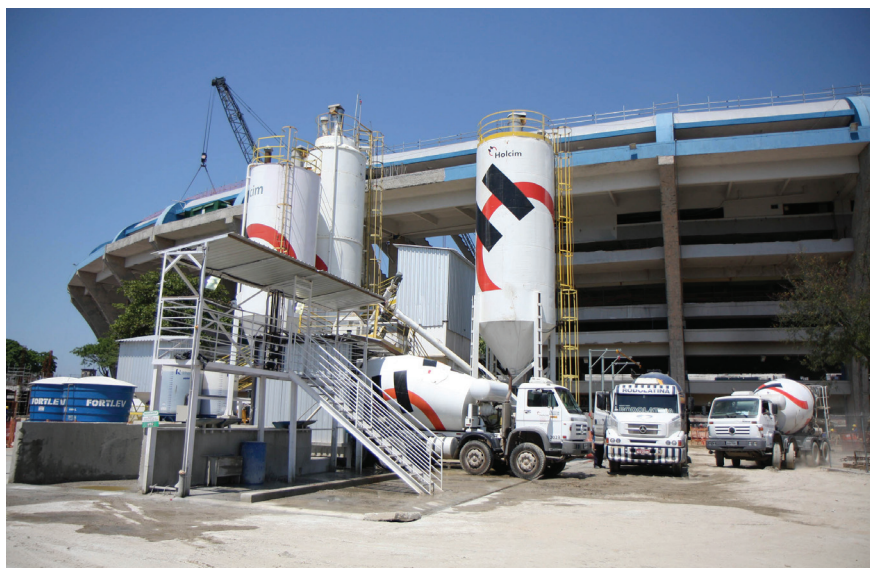
▼ Central de concreto da Holcim instalado ao lado do canteiro de obras prepara as fundações das arquibancadas do novo Maracanã
