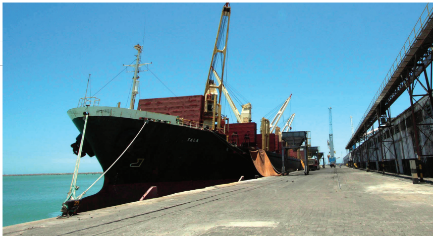
▲ Porto de Pecém conclui obras de ampliação do Terminal de Múltiplo Uso (TMUT)
