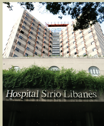
Hospital Sirio-Libanês - bloco C São Paulo SP
