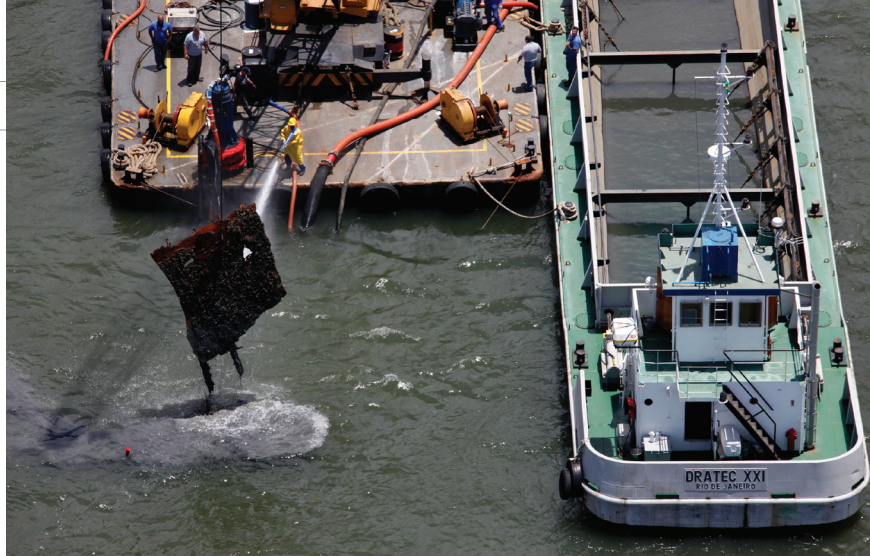
▲ Complexo viário visa melhorar a logística de acesso ao porto
