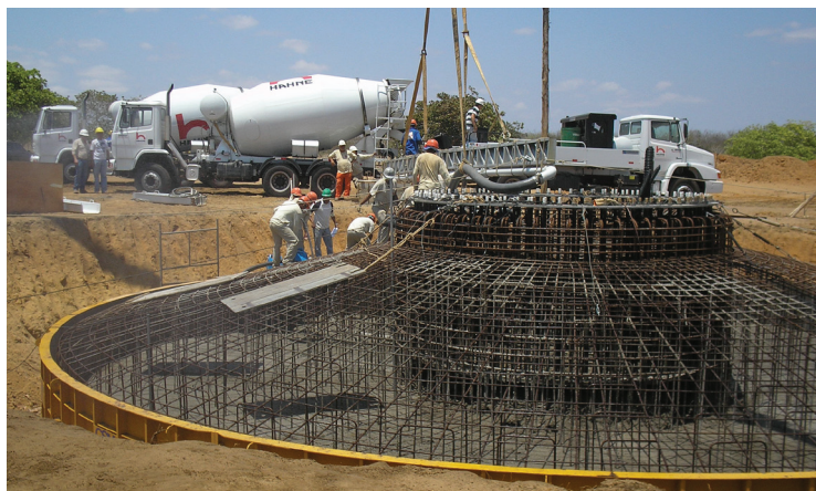
► A Construtora Hahne, responde pela construção das bases de concreto onde são fixadas as torres, cada uma delas exigindo o emprego de 400 m³ de concreto
