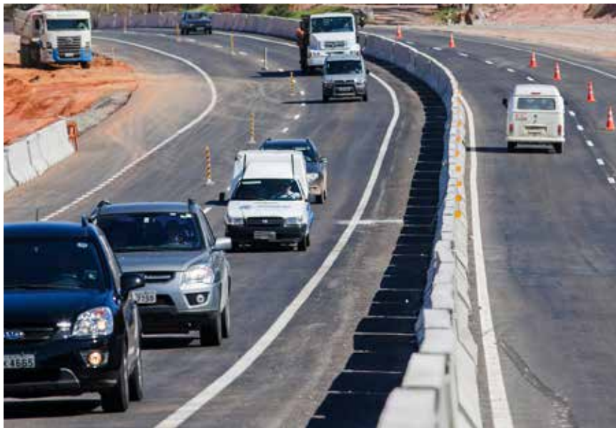
◀ Tamoios - Trecho Planalto da Tamoios, obras em pleno andamento
