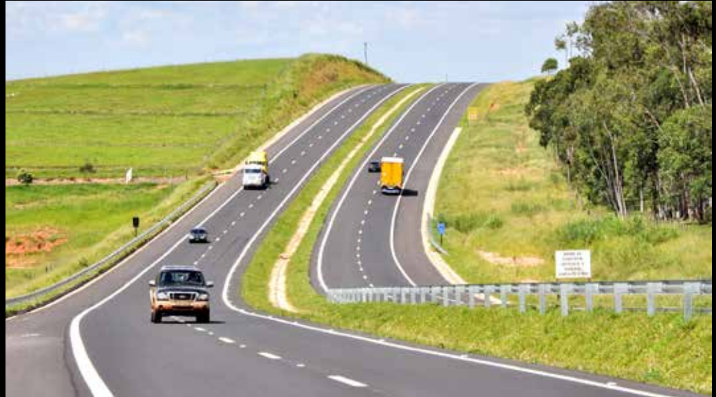
▶ SP-294, em Bauru, desafio de abrir caminhos para o escoamento da produção
