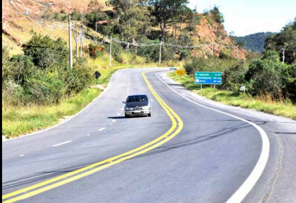
► SP-171, em Cunha, obras visam desenvolver a região
